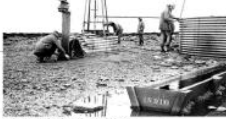
••• Construcción de Madero, 12 de agosto de 1965. Foto: archivo de la UBA.
